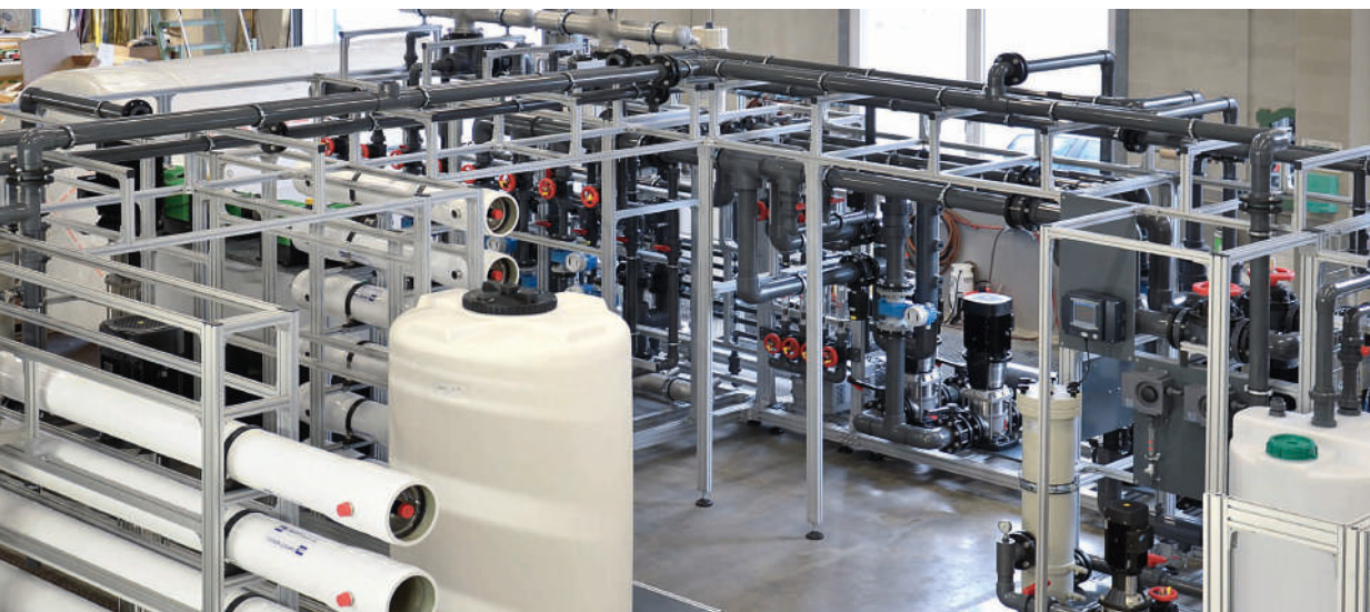
Flexibles Leichtbau-Gestell aus Profilen der Serie 40 für eine Salzwasseraufbereitungsanlage
