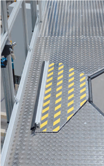
Montageklappe im Podestboden mit Antirutschbelag
