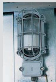
Die Elektroinstallationspakte sind je nach Ausführung auf die jeweiligen Erfordernisse abgestimmt. Die Ausführungen für aktive und passive Lagerung enthalten u. a. eine explosionsgeschützte Wandlampe innen.
