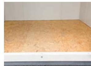
Isolierter Boden mit OSB-Platte
