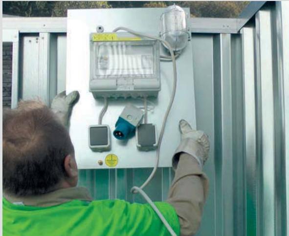
Das Elektroinstallationspaket für FLADAFI® Materialcontainer besteht aus einer für den Selbstanbau vormontierten Grundplatte mit fertig verdrahtetem Sicherungskasten mit Fehlerstromschutzschalter, Leitungsschutzschalter 16 A, einer Wandlampe und einer SCHUKO®-Steckdose.
