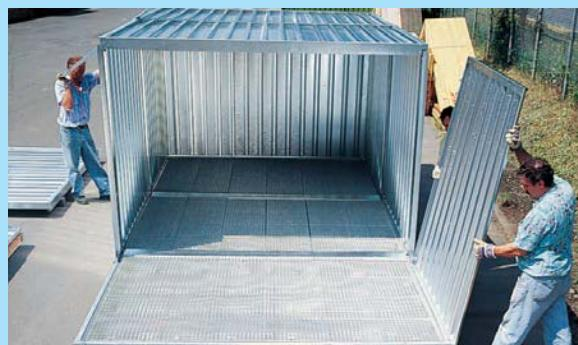
Wannen ausrichten und Verbindungselemente einlegen ...
