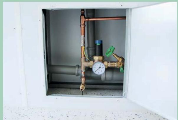
Wartungsklappe mit Absperrventil, Druckminderer und Entleerung
