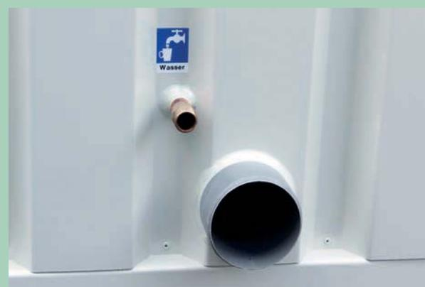
Zu- und Abwasseranschluß: Leicht zugänglich an der Rückseite
