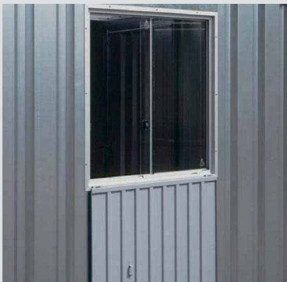
Die Baustellencontainer können auch mit Aluminium-Schiebefenstern mit nach unten klappbarem Schlagladen ausgestattet werden. Das Fenster mit Sicherheitsglas ist 733 x 805 mm groß.
