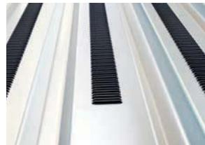
Lüftungskiemen sorgen bei der passiven Lagerung für die nötige Eigenbelüftung.
