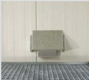
Durch die mechanische Belüftung bei der aktiven Lagerung erfolgt eine Luft-Durchflutung unterhalb des Gitterrostes und innerhalb des Containers.
