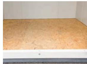
Isolierter Boden mit OSB-Platte
