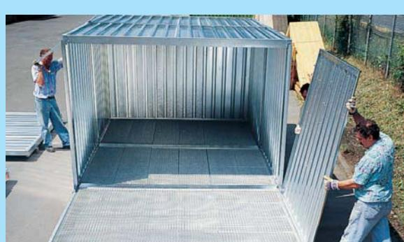
Dachelemente auflegen. Dach- und Seitenverbindungsteile montieren – fertig!
